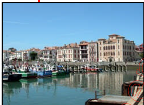
La Maison de l'Infante se dresse en bordure du port. (Photo JL)
